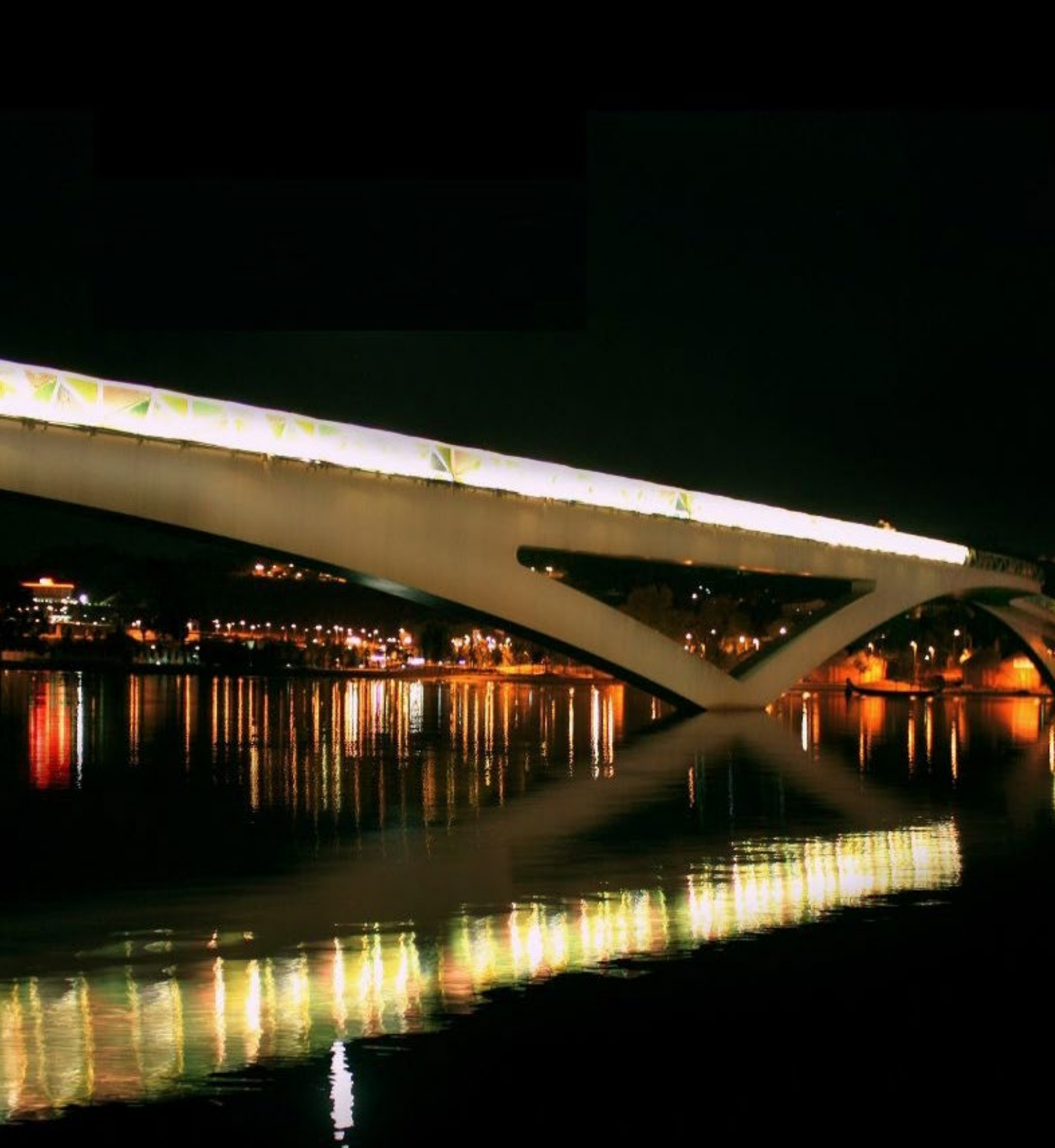
FIGURE 4.10 PEDRO E INÊS BRIDGE
